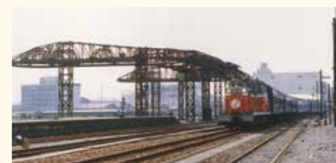
埠頭まで伸びていた鉄道。荷揚げ用テルファーは現存(昭和59年/個人蔵)
