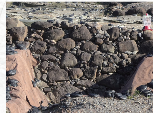
下段右：駿府城公園 天守台発掘調査現場の石垣
